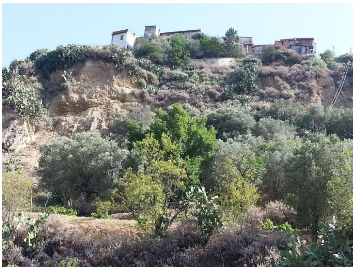
FOTO N°9: particolare del distacco del terreno prominente lungo il fronte sud-ovest verificatosi il 30 aprile 2016 (AREA 4 in Tav. N°16)
