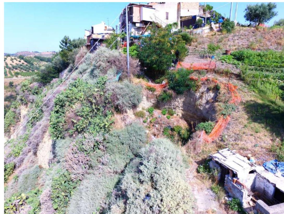
FOTO N°16: particolare dello sprofondamento nelle vicinanze dei fabbricati con interruzione del preesistente percorso pedonale (AREA 3)
