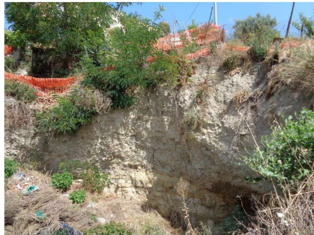
FOTO N°18: vista della parte interna della voragine che si è generata a seguito dello sprofondamento del terreno raffigurato nelle precedenti foto
